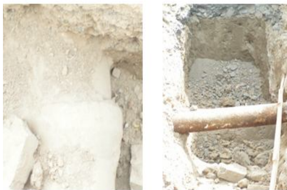
图 7 开挖后的管线照片
